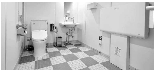
多目的トイレ
