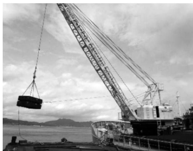
浚渫クレーンの過荷重テスト(13.8トン)
