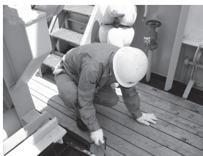
写真－1 木甲板の打音による腐食調査
