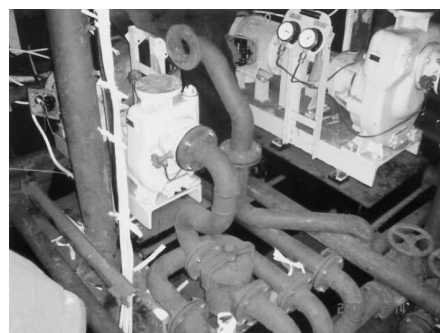
(修復後の機関室)
