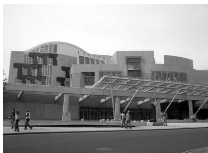
写真-2 スコットランド議会棟
