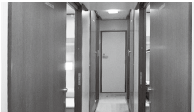
居室通路と引戸
