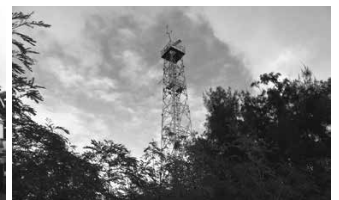
海上監視用レーダー鉄塔
