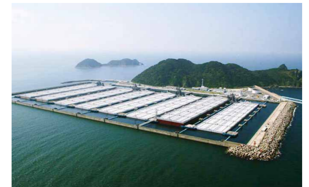
石油備蓄基地へ赴き防食劣化調査を行う
